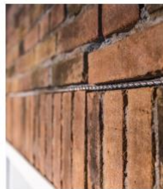
Constructief gevelherstel
