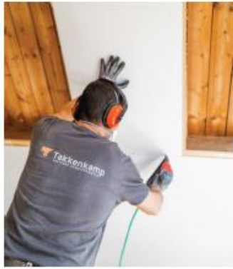
(Na)isolatie van dak, spouwmuur en vloer
