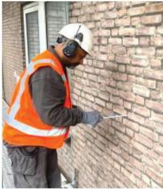
Na-verankering van spouwmuren
